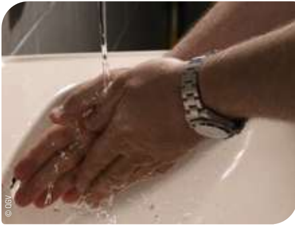
Abb. 43: Der Vorraum muss über geeignete Händewascheinrichtungen verfügen.
